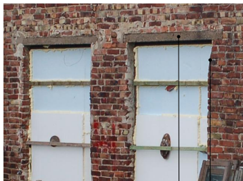
betoonsillused likvideeritakse, taastatakse esialgne sillus esialgsel kõrgusel
