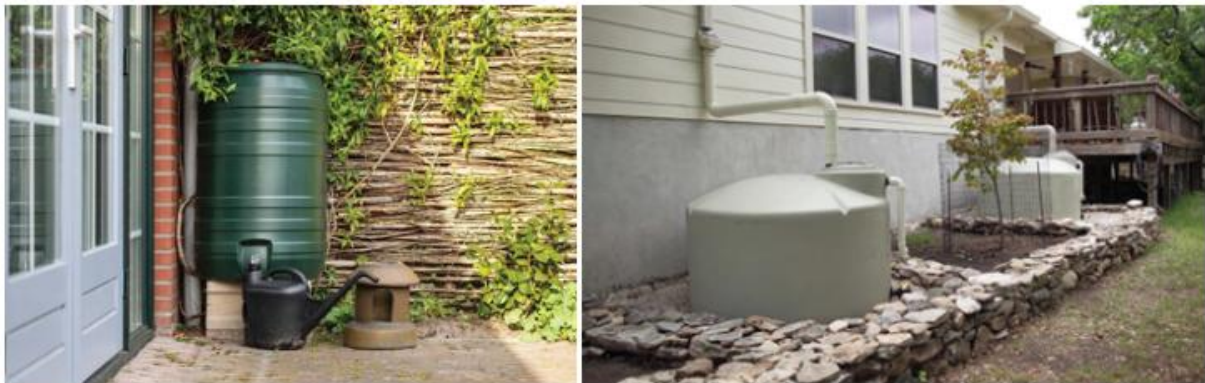
Joonis 6.3 Näiteid vihmavee kogumise lahendustest (vasakul 26 lahendus vähesese kastmisvee vajaduse katmiseks ja paremal 27 lahendus suurema kastmisvee vajaduse katmiseks).
