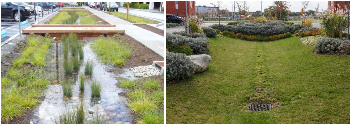
Joonis 6.1 Näited säästlikest sademeveesüsteemidest (paremal: vihmapeenar 17 , vasakul: nõva 18 )
